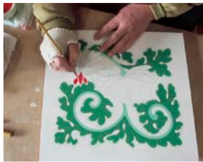
天井絵修理の様子
