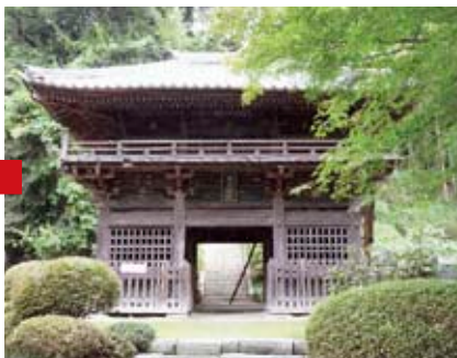
修理前の寄棟、瓦葺で背の低い仁王門
