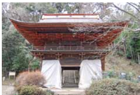
保存修理工事中の小山寺仁王門
