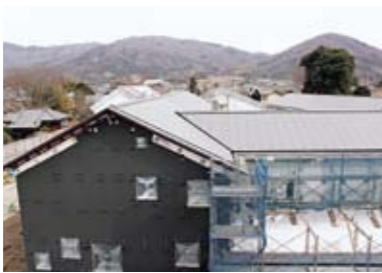
本年度、早期完成に向けて工事が進められている(仮称)多目的複合施設(西側からの風景)
