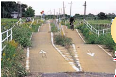
道路がノコギリの歯のようになり、2車線に分かれています。進行する車線を守って安全走行しましょう。
