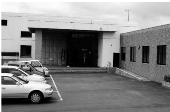
地域住民の憩いの場として活用されている農村環境改善センター(加茂部地区)
