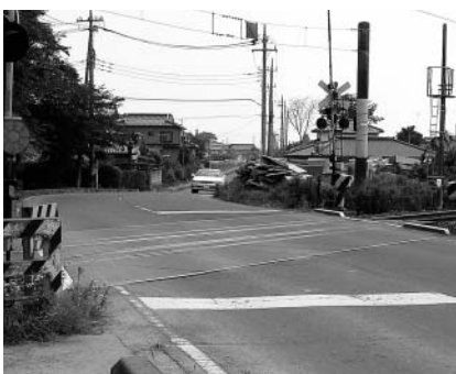
踏切の安全対策を（青木地内）
