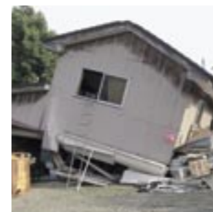
建築士会桜川支部では、大規模な地震により、傾くなどの被害を受けた建築物が、余震による第二次災害を引き起こさないよう、被災建築物の危険度を判定する「被災建築物応急危険度判定士」を地震被災地に派遣する社会貢献活動を行っています。
