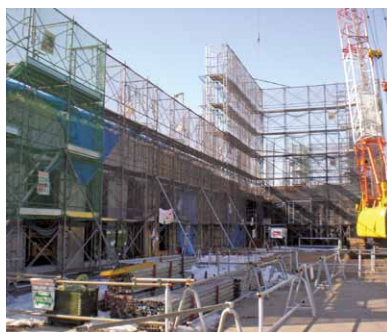
躯体部分の工事
