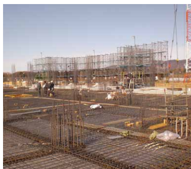
2階床部分の配筋
