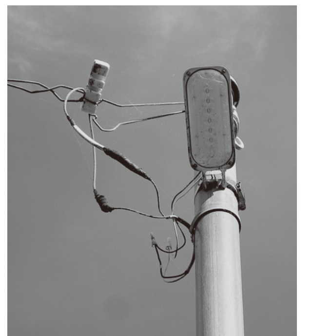
LEDに交換された防犯灯（岩瀬地区）
