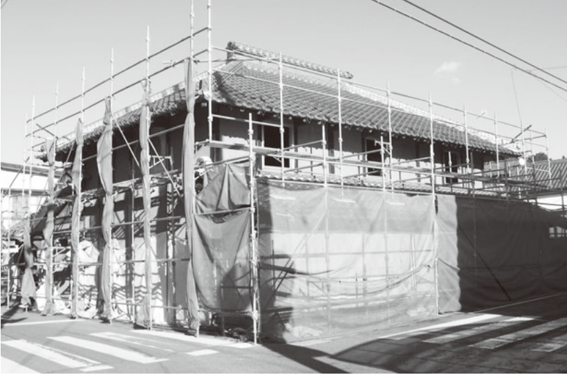
修復中の旧高久家（真壁町真壁地内）
