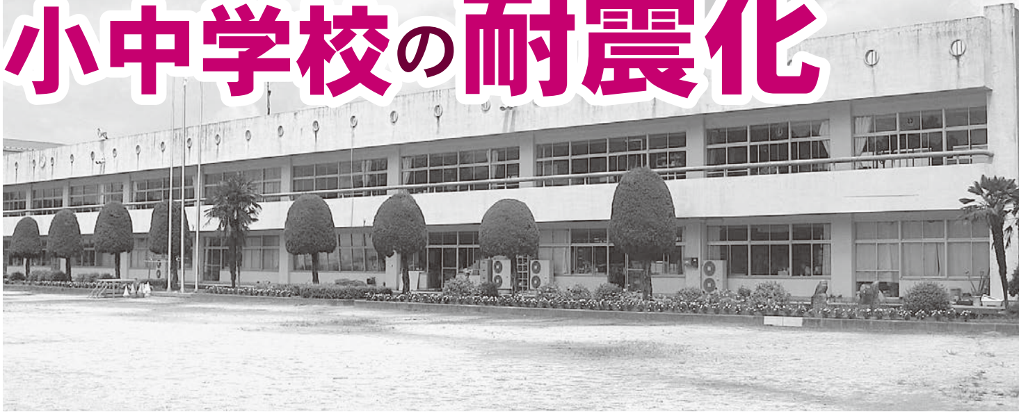
耐震補強及び大規模改修工事を行う岩瀬東中学校
