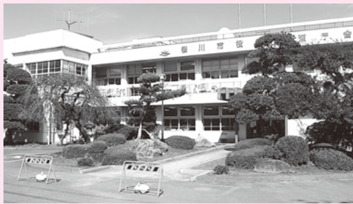
約50年が経過した岩瀬第1庁舎
