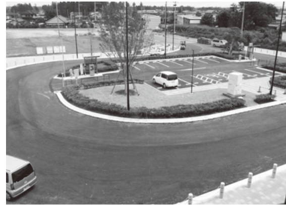
駐車場が整備されている岩間駅東口
