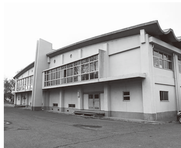
真壁小学校体育館
