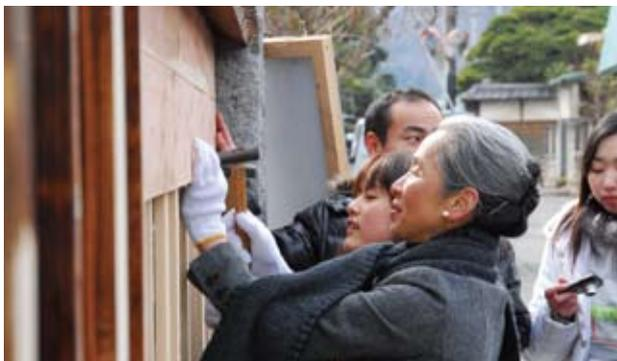
市民の協力でブロック塀が板塀に変身 板塀はブロック塀の転倒防止機能を補完している
