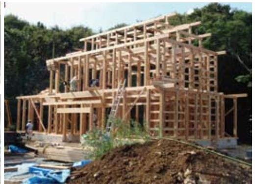
木造軸組構法（もくぞうじくぐみこうほう）とは、日本で古くからある伝統工法を簡略化・発展させたもので、在来工法とも呼ぶ。その構法は、主に柱や梁といった軸組（線材）で支えるため、壁の配置に制約が少なく、大きな開口部をつくれるので、通風や採光に優れた間取りをつくることができる。奈良時代からの建造物が残っているように、100年以上持つ家をつくるには最も適している工法の一つである。
