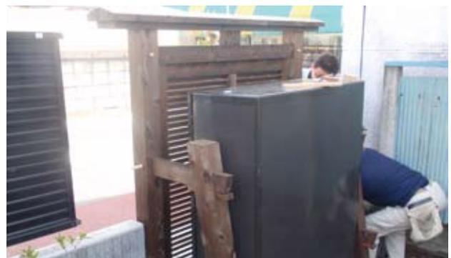
電線類の地中化にともない、地上に設置される電源供給用の地上機器を板塀で隠す修景工事
