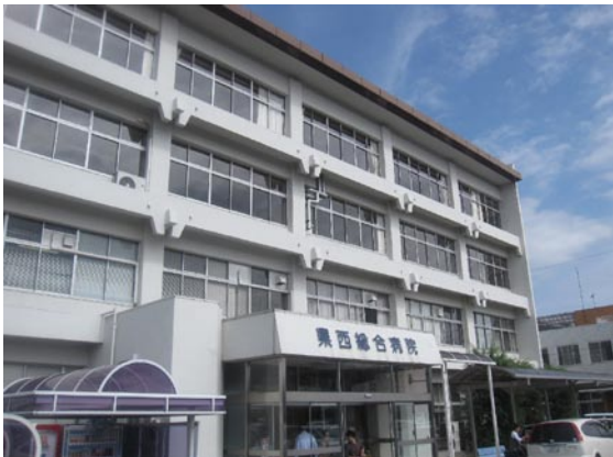
東日本大震災で被害を受けた県西総合病院
