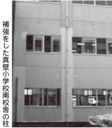
補強をした真壁小学校南校舎の柱
