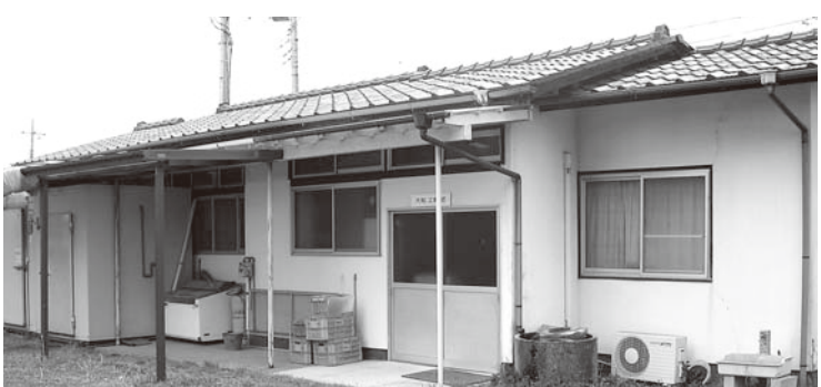
指定管理者の契約をしている旧大和地域にある加工施設。ゆずを使ったマーマレード等の加工食品を生産している。
