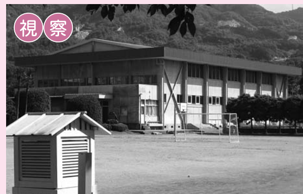
9月17日、大和中学校建設現場と樺穂小学校体育館を視察しました。
