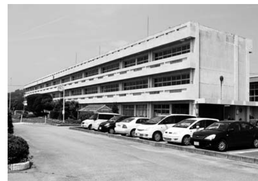
耐震補強工事が予定されている岩瀬西中学校
